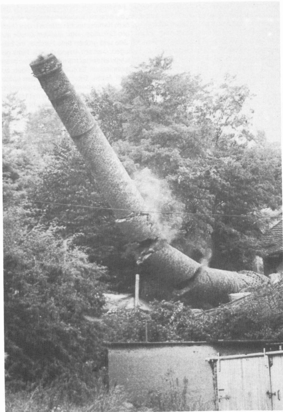
Bild 6: Präzisionssprengung eines Kamins 1980 an der ehem. Paqué-Brauerei in St. Wendel.
