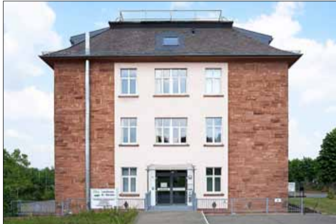
In einem der ehemaligen Kasernengebäude in der Tritzler Straße in St. Wendel ist die Kommunale Arbeitsförderung untergebracht. Foto: pdk
